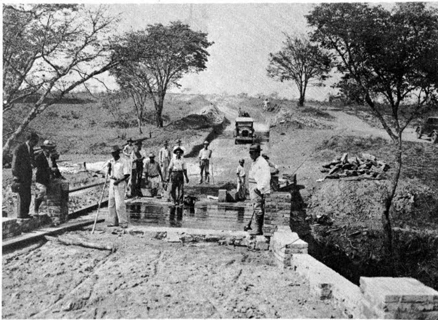
Trabalhadores na construção da ponte sobre o Rio Tamanduá, junto ao Prefeito Fausto Alvim. 1.935 - (Arquivo DPH/FCCB)
